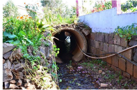
Figura 10 - Trecho canalizado no Lajeado Belmonte, com tubulação nas passagens das ruas.
