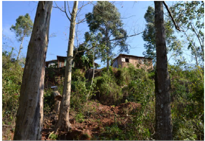
Figura 19 - Edificação em risco iminente na zona urbana consolidada do município de Belmonte/SC.
