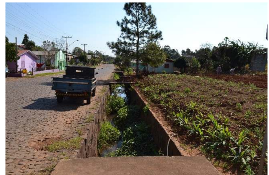
Figura 11 - Canalização de curso de água localizado no espaço das caçadas.
