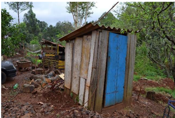
Figura 30 - “Patente” com disposição de esgoto diretamente no solo, unidade em uso em residências sem sanitários.
