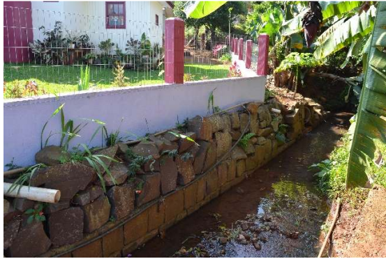
Figura 9 - Trecho canalizado no Lajeado Belmonte, com a fixação das margens e parte superior aberta.
