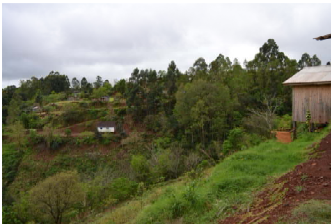
Figura 20 - Edificação em risco iminente na zona urbana consolidada do município de Belmonte/SC.
