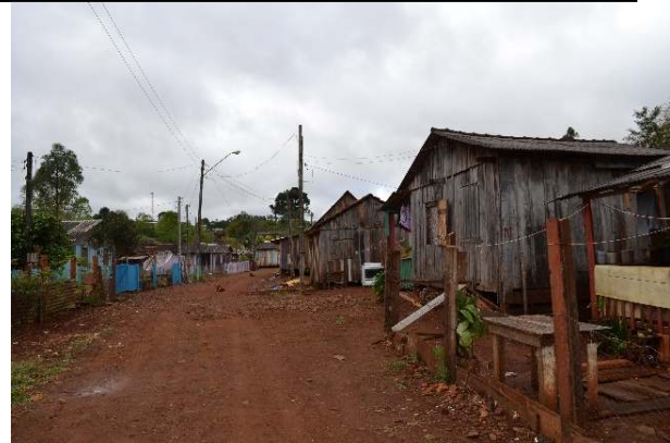
Figura 29 - Condições de urbanização e presença de edificações precárias.
