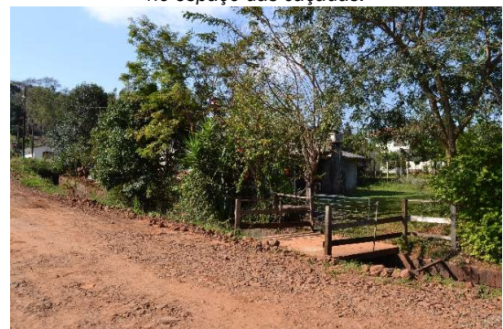
Figura 12 - Pontilhão construído para acesso à residência.
