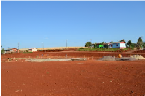
Figura 16 - Imagem da Escola que está sendo construída.
