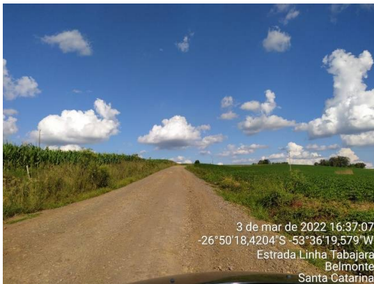
Trecho a pavimentar
