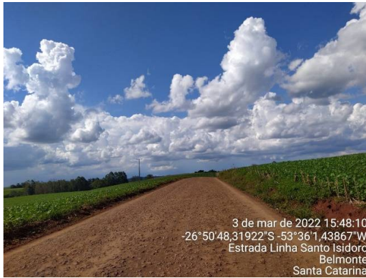
Trecho a pavimentar
