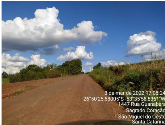
Trecho a pavimentar
