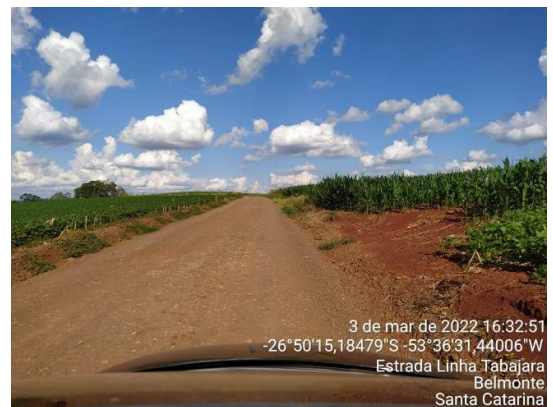
Trecho a pavimentar
