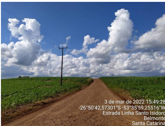
Trecho a pavimentar
