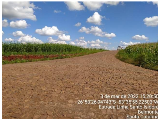
Início do trecho a pavimentar
