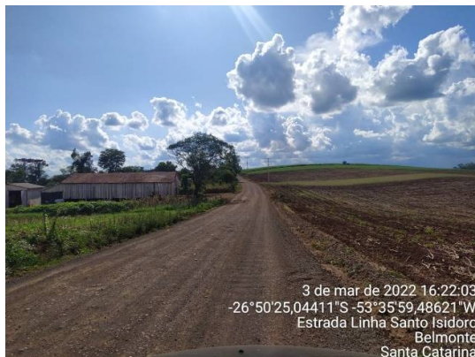
Trecho a pavimentar
