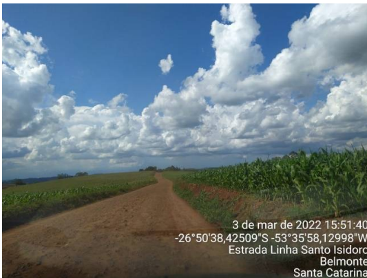
Trecho a pavimentar
