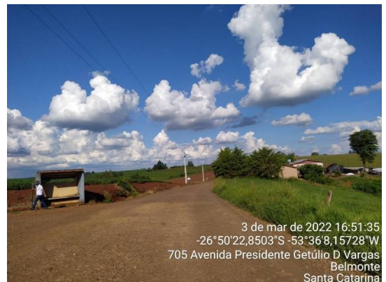
Trecho a pavimentar
