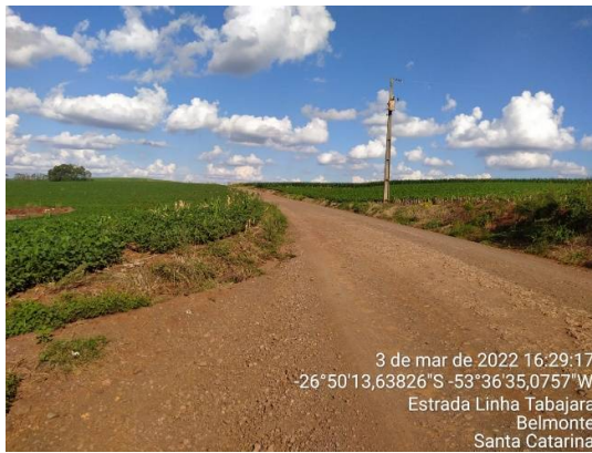
Trecho a pavimentar
