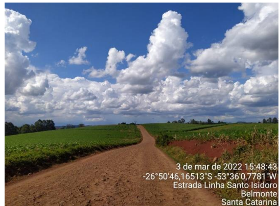
Trecho a pavimentar
