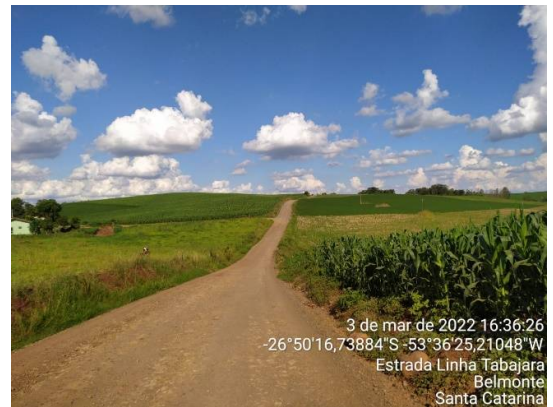
Trecho a pavimentar
