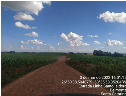
Trecho a pavimentar
