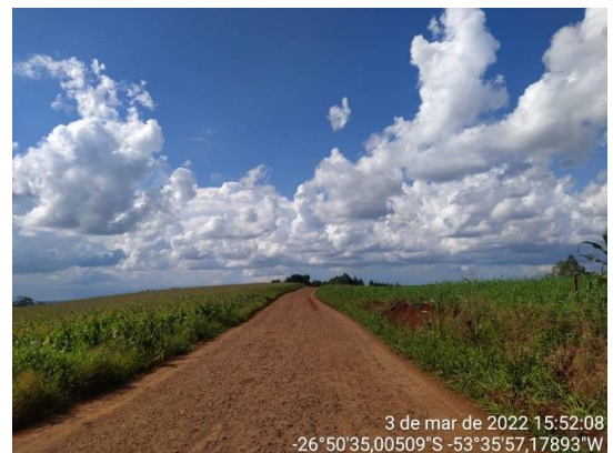
Trecho a pavimentar
