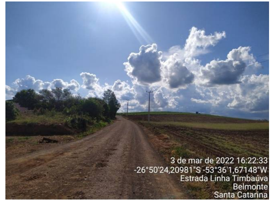
Trecho a pavimentar
