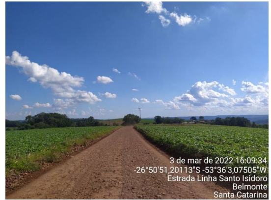
Trecho a pavimentar
