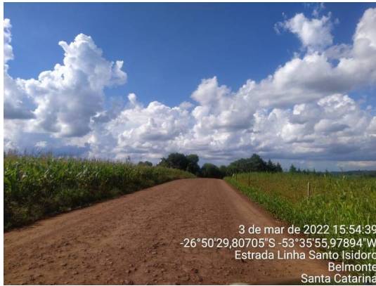
Trecho a pavimentar
