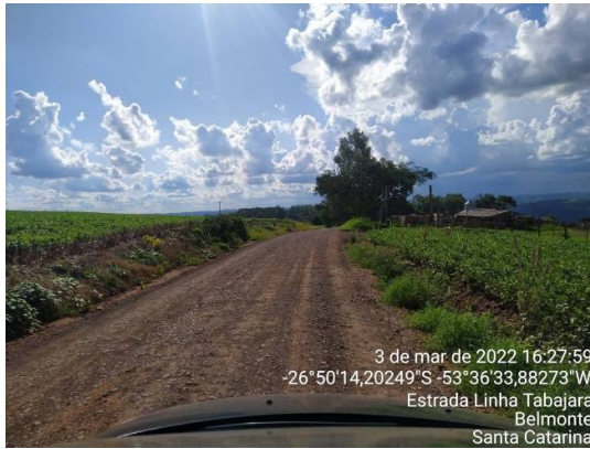
Trecho a pavimentar
