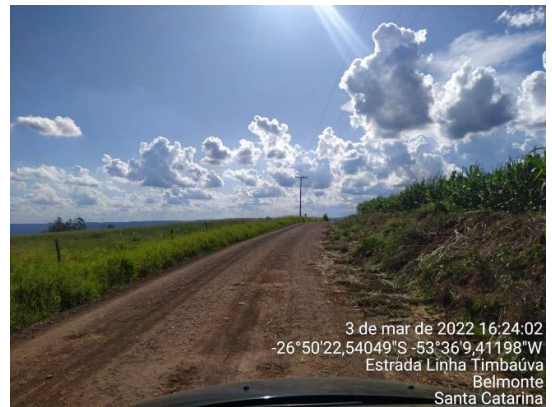
Trecho a pavimentar
