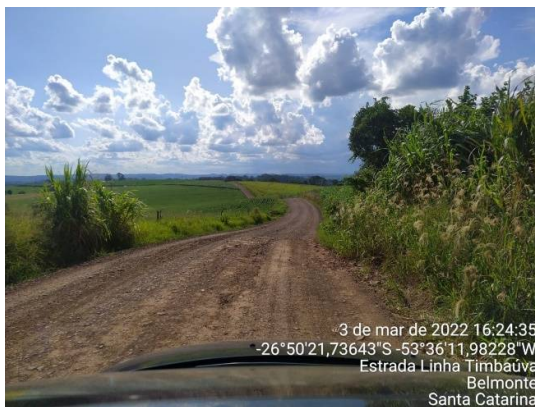
Trecho a pavimentar
