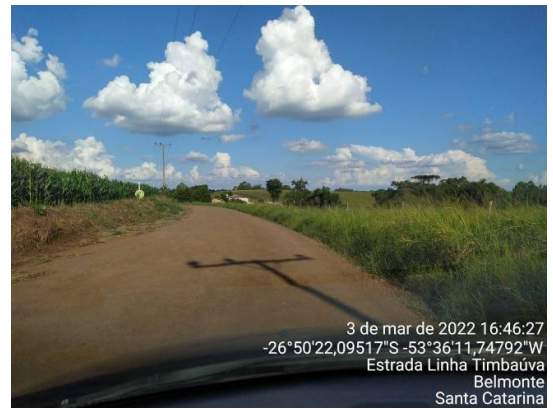
Trecho a pavimentar
