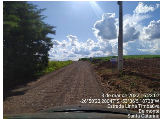
Trecho a pavimentar
