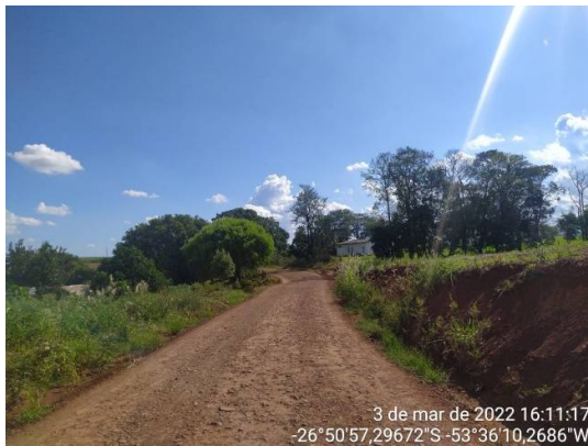
Trecho a pavimentar
