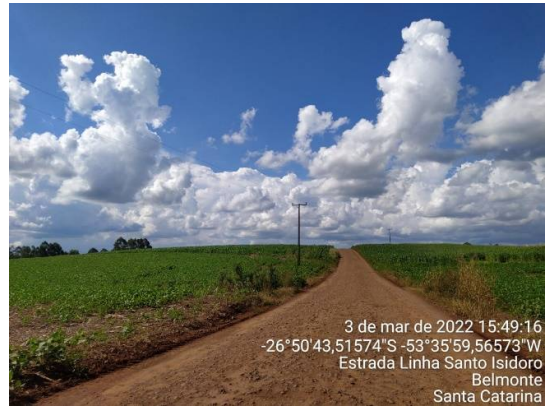
Trecho a pavimentar
