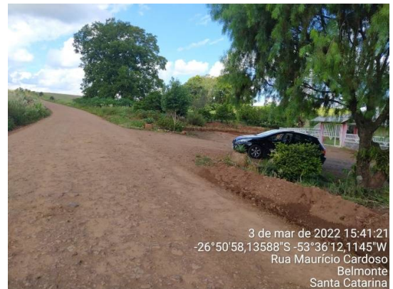
Trecho a pavimentar
