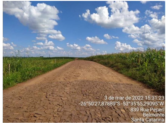
Início do trecho a pavimentar
