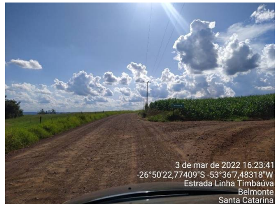
Trecho a pavimentar
