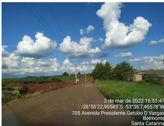
Trecho a pavimentar
