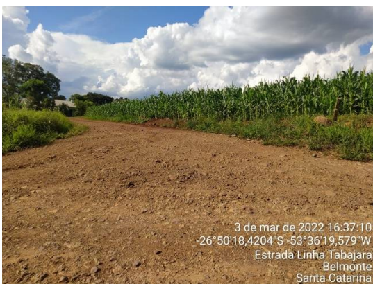
Trecho a pavimentar
