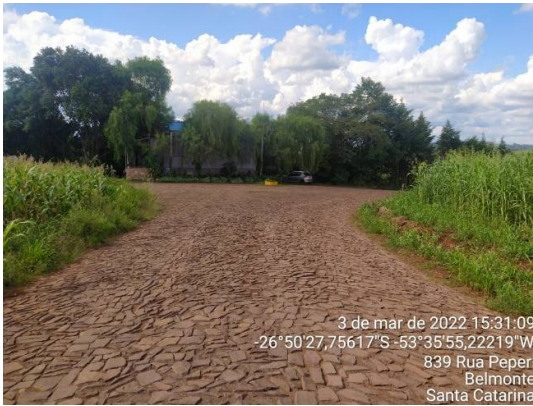
Início do trecho a pavimentar
