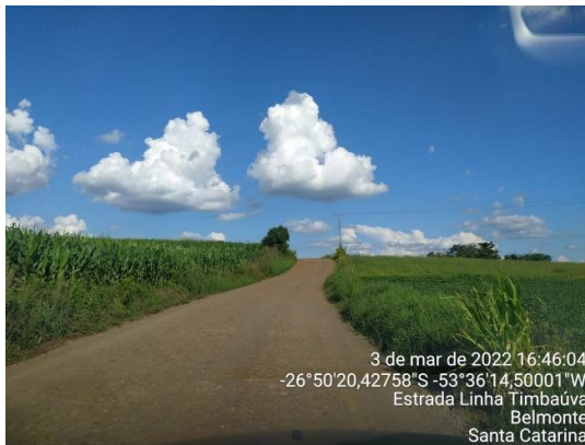
Trecho a pavimentar
