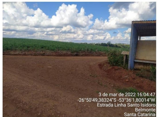
Trecho a pavimentar
